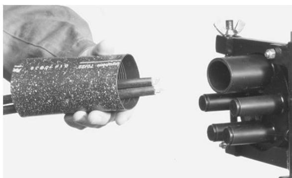
3.2 Вирівняйте кабелі до загальної довжини та відріжте зайве, залишивши запас для майбутнього монтажу. Запас кабелю від муфти до каналів оглядових пристройів, або кріплень кабелю повинні бути з'єднанні через кожні пів метру ізострічкою. Протягніть кабелі через термоусаджувальну трубку відповідно кабельного вводу;
