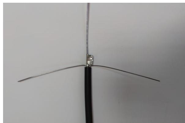
3.4 Для забезпечення безперервності екрану необхідно зробити продольний надріз оболонки кабелю довжиною 25 мм від її краю. За допомогою інструменту зніміть оболонку не пошкоджуючи стальну гофротрубку. З'єднайте стальну гофротрубку з комплектом продовження екрану, після використовуючи ізострічку заізолуйте місце з'єднання;
