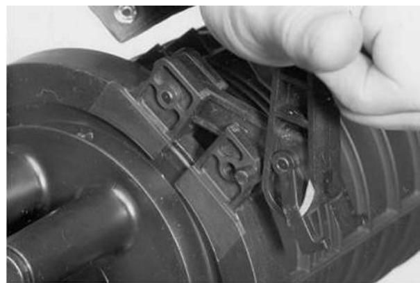
4.9 Закрійте муфту та закрутіть гвинт на хомуті;
